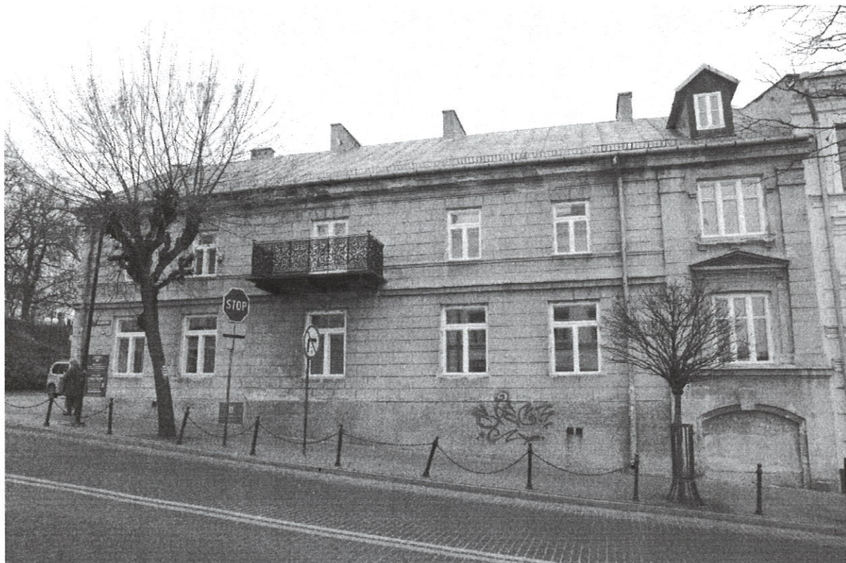
Fotografia 11. Elewacja północna budynku.
