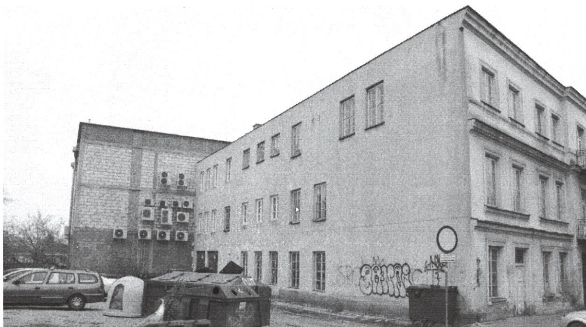
Fotografia 19. Elewacja południowa budynku.
